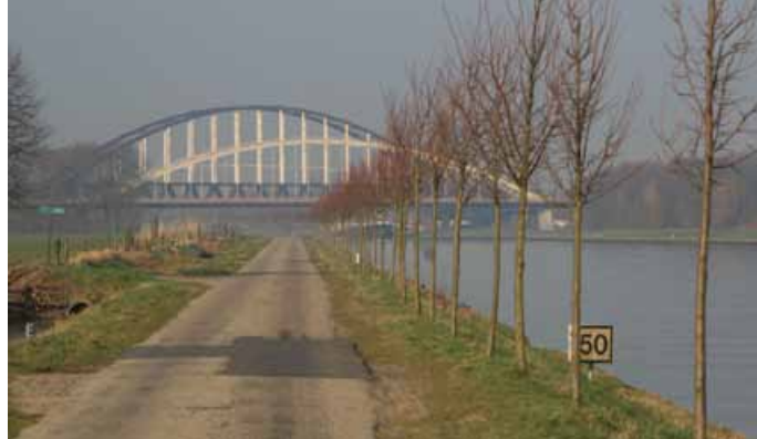
Het Amsterdam-Rijnkanaal met parallelweg en bruggen
