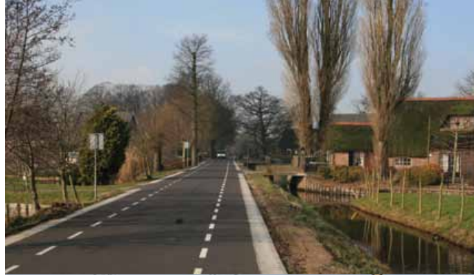
Smal wegprofiel binnen een historisch bebouwingslint
